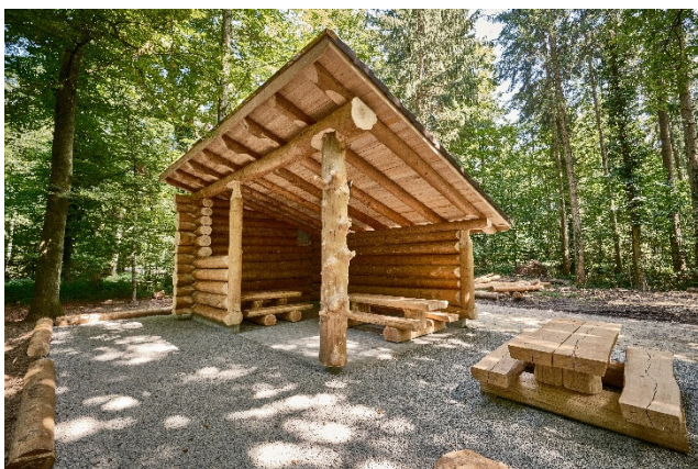
Bild: Waldunterstand in Fahrwangen Quelle: Forstbetrieb
